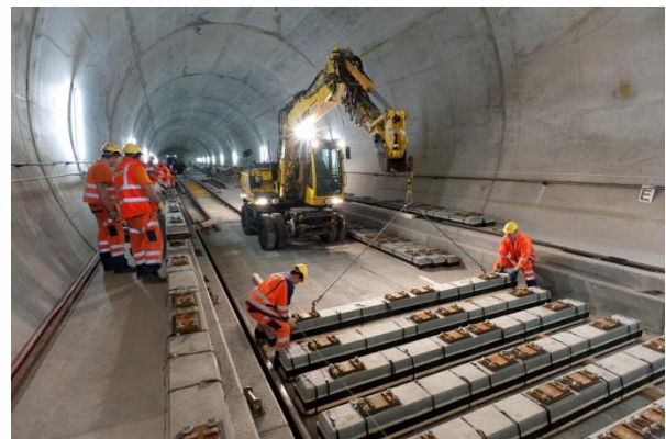
Abbildung 1: Gleisbauarbeiten im Gotthard-Basistunnel – Foto: © Alp Transit Gotthard AG
