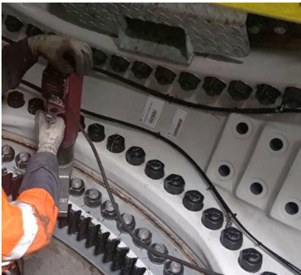
Abbildung 5: Verschraubungen bei beengten Verhältnissen im Rotorgehäuse.
