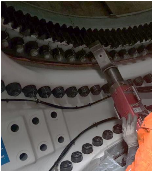
Abbildung 2: Der alkitronic EF 300 Plus im Einsatz bei der Rotorblattverschraubung.
