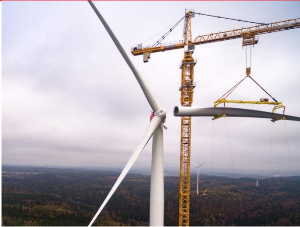
Abbildung 4: Anbringen der Flügel. Foto: © Max Bögl Wind AG, Fotograf: Holger Hessenthaler.
