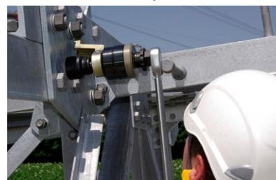
**alkitronic® M** bei Montagearbeiten an Strommasten, präzises Anziehen mit einem Drehmomentschlüssel.
